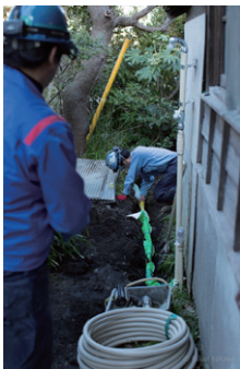
老朽化した ガス管を交換する。
