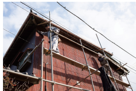
老朽化した外壁を張り替えるのは、 足場を組む大がかりな修理になる。
