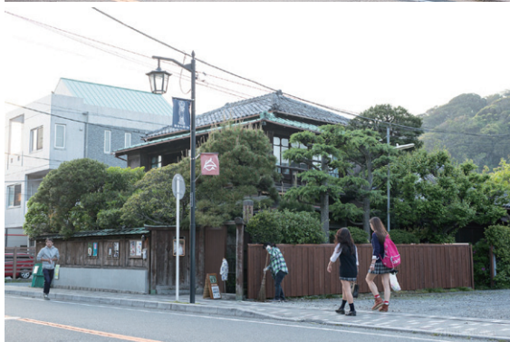
駐車場との塀は味気ないトタンから 味わいのある木製に変えた。
